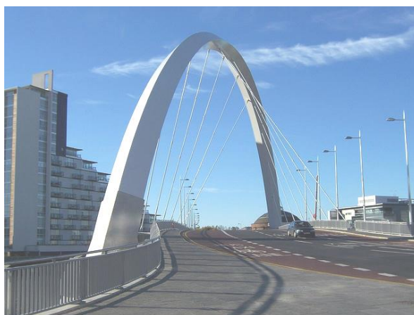
Рис. 3.22. Мост Hulme Arch Bridge. Великобритания
